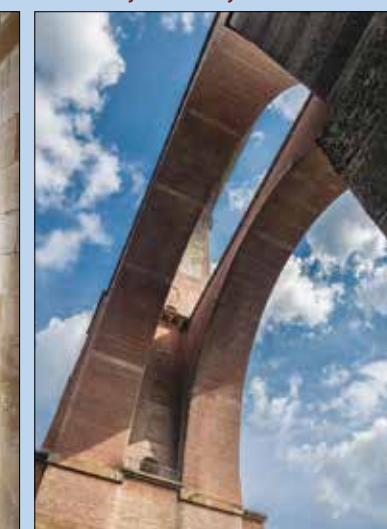
▼ Pohledy dovnitř mostu prozradí skutečnou složitost jeho konstrukce i další skryté oblouky.
