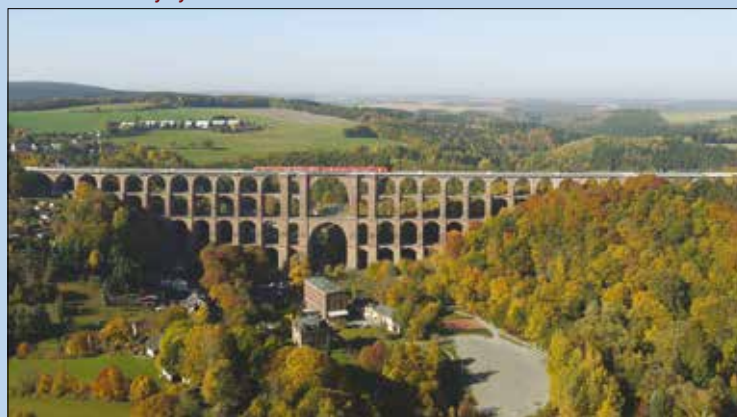
▼ Stavba přišla na současných 1,8 miliardy korun a je dnes neodmyslitelnou dominantou krajiny.
